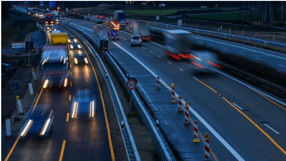
Autos und Lastkraftwagen fahren bei Dreenkrögen (Mecklenburg-Vorpommern) durch die Baustelle für die Brücken für das Autobahnkreuz der künftigen Autobahn A 14 zwischen Schwerin und Magdeburg und der Autobahn A 24
